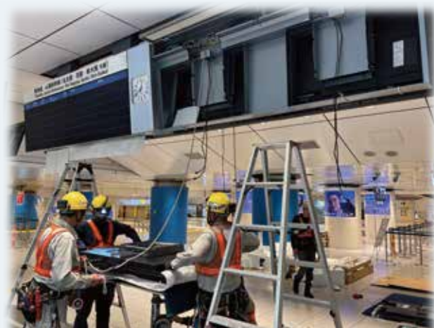
作業風景（JR 東海工事）
