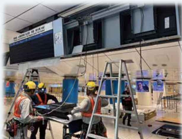
作業風景（JR 東海工事）
